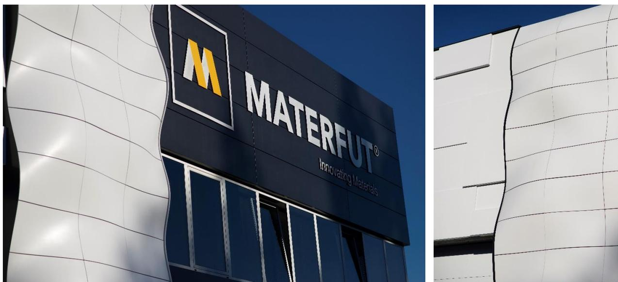
Siège de Materfut®, au Portugal. Façade avec panneaux en Corian® Exteriors (réalisés avec Corian® Solid Surface) présentant différentes possibilités de forme, y compris des panneaux de forme organique créés par dessin paramétrique ; Projet de l'architecte Alexandre Sousa Lopes ; fabrication et pose par Materfut® ; Image par Materfut®, tous droits réservés.
