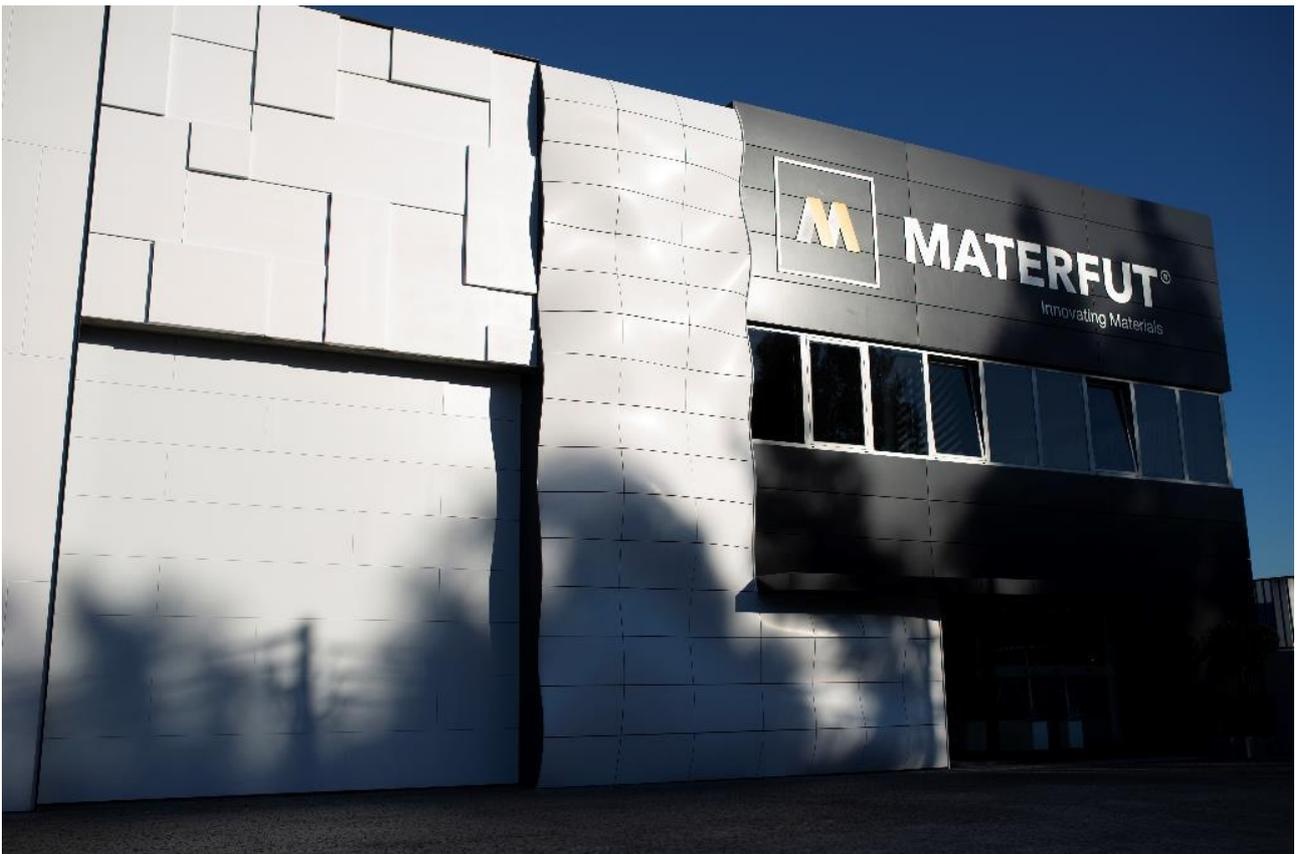
Siège de Materfut®, au Portugal. Façade avec panneaux en Corian® Exteriors (réalisés avec Corian® Solid Surface) présentant différentes possibilités de forme, y compris des panneaux de forme organique créés par dessin paramétrique ; Projet de l'architecte Alexandre Sousa Lopes ; fabrication et pose par Materfut® ; Image par Materfut®, tous droits réservés.
