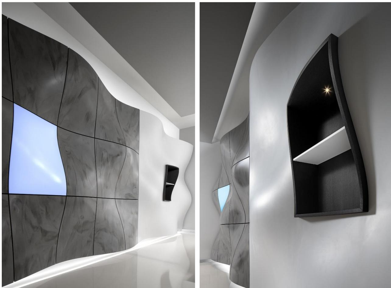
*La paroi de Linea Pannelli est réalisée en Corian® Solid Surface avec des panneaux tridimensionnels en Glacier White et Artista Dust grâce au design paramétrique. Elle permet aux architectes et aux designers d'imaginer des possibilités créatives infinies ; photo de Linea Pannelli ; tous droits réservés.*
